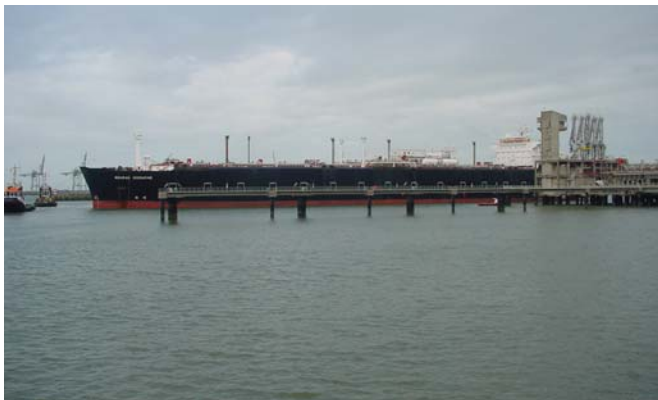
LNG carrier at the existing jetty in Zeebrugge
