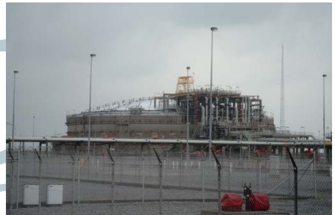
LNG tank Zeebrugge
